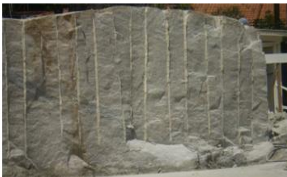
Figura 10 - Pré-fissuramento de materiais de 3ª categoria
