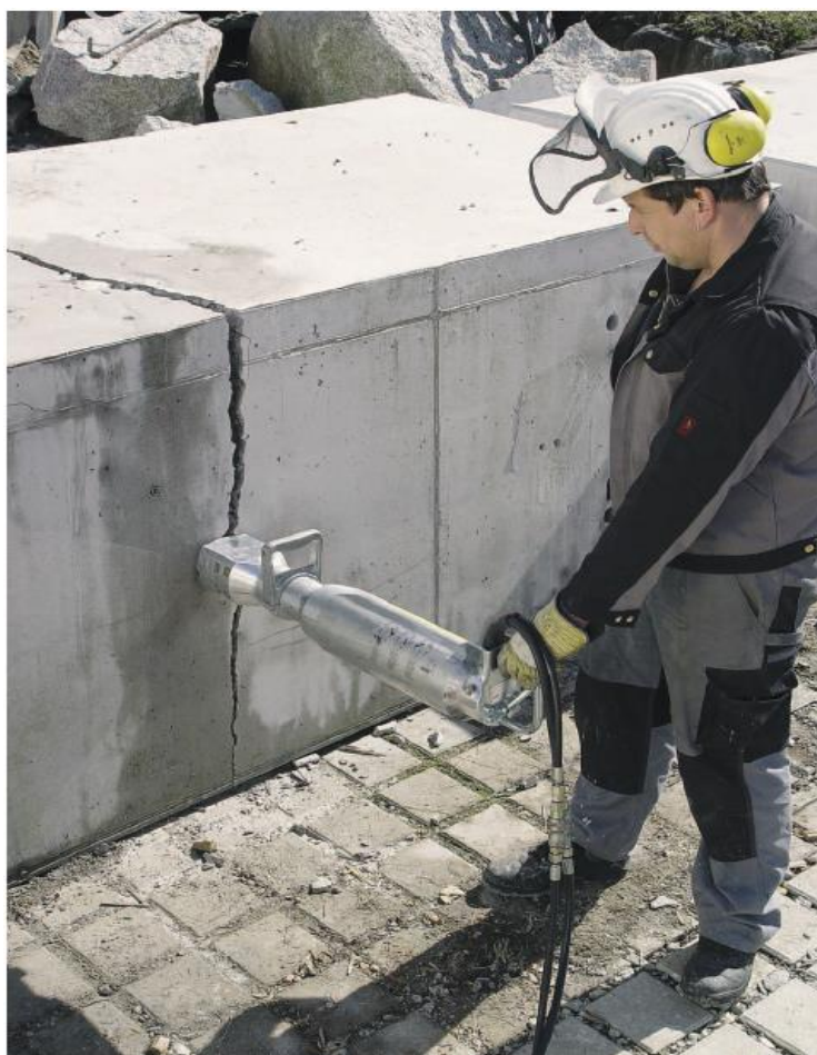
Figura 09 - Cunha hidráulica tipo Darda utilizada no desmonte a frio de rocha
